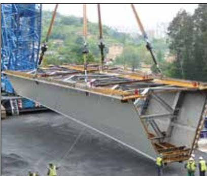
▼ Verankerungsspezialisten setzen das SyncHoist-System ein, um bei der Positionierung eines 1140 t schweren Moduls eines Kernkraftwerks jeden Hubpunkt separat oder zusammen synchronisiert präzise einzustellen und zu überwachen.
