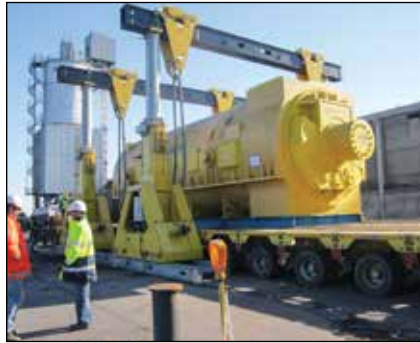
Anheben und Einladen einer Turbine im Verladehafen
