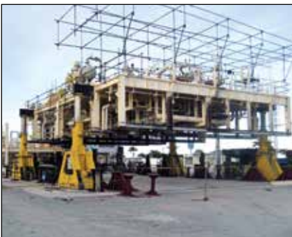
Montage eines Moduls einer Offshore-Ölförderplattform
