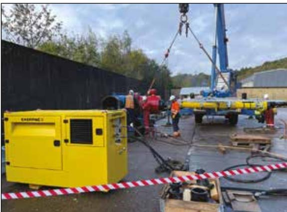
◀ Enerpac MHT2460-H Hot-Tapping-Maschine, angetrieben von einem Power Pack der PP44-Serie.
