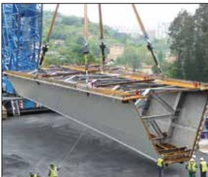
▼ Zum gleichmäßigen Anheben der Stahlbaugruppen der zentralen Kommandoaufbauten des Schiffs wurde ein SyncHoist-System verwendet.
