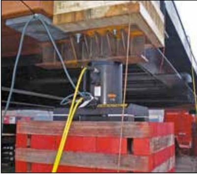
◀ *Typischer Einsatz eines Stufenhubsystems:
