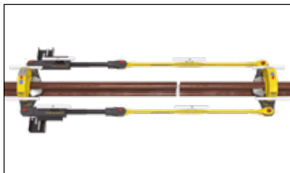
▲ La tensione modulare da 70 tonnellate, mantiene la rotaia in posizione neutra durante il processo di saldatura.
