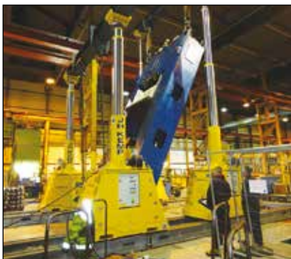
▼ Gru a cavalletto idrauliche SL400 impiegato per lo scarico e l'installazione di una nuova pressa di stampaggio.
