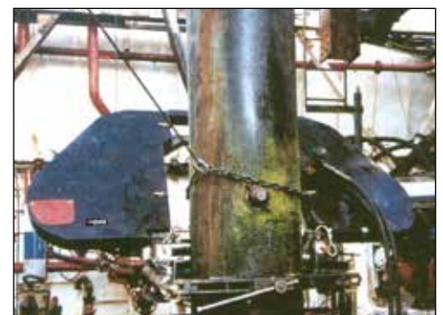
▼ Lavoro di smantellamento con sega a nastro.
