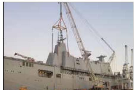
Sollevamento e posizionamento del carico sincronizzati
