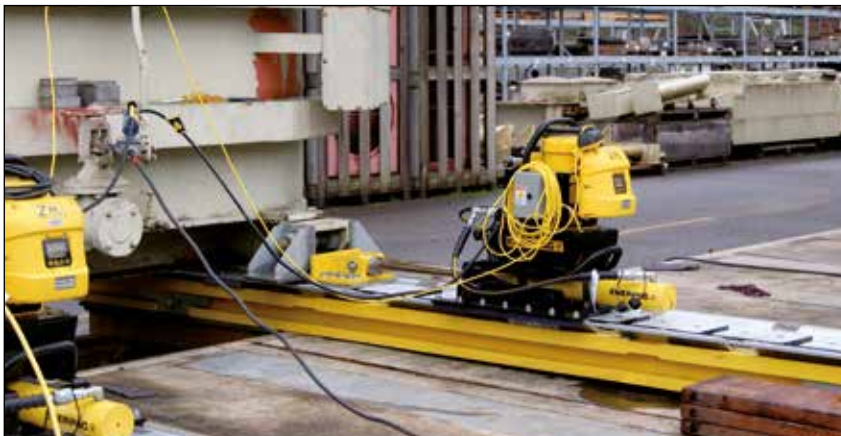
▼ Il sistema idraulico di scorrimento ad altezza ridotta consentirà al team addetto alla manutenzione di manovrare e trasportare i trasformatori ad accesso limitato.
