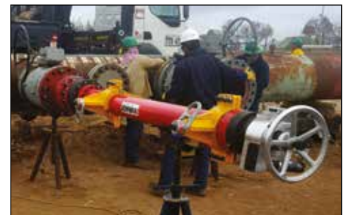
▲ Utilisation de la machine de piquage en charge CHT3000 sur des pipelines de l'industrie pétrochimique.
