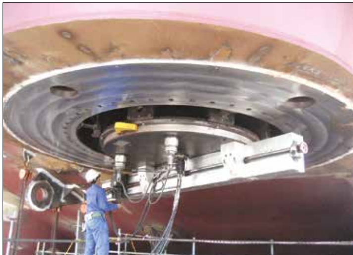
▼ Fraisage d'une bride de propulseur de navire.
