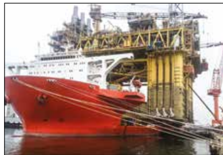
Super-levage et pose synchronisés
