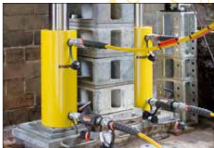
Levage et pose de pont
