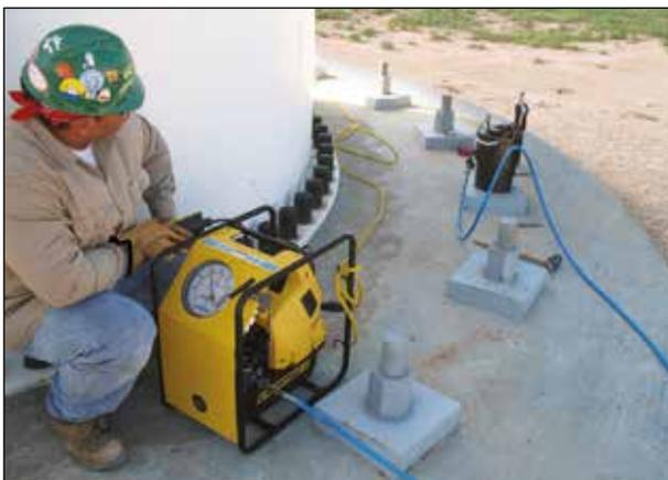
◀ La pompe ZUTP-1500 robuste et légère est idéale pour réaliser sans effort la mise en tension de goujons dans les emplacements difficilement accessibles, en travaillant deux fois plus vite qu'avec les pompes concurrentes. Son format compact permet de l'utiliser même dans les endroits exigus.
