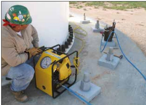
◀ *La centralina ZUTP-1500 risulta quindi resistente, leggera, compatta e in grado di entrare nelle aperture più strette, nonché di garantire un funzionamento semplice e di effettuare il tensionamento dei bulloni in posizioni remote a una velocità massima doppia rispetto a quella offerta dalle centraline della concorrenza.*
