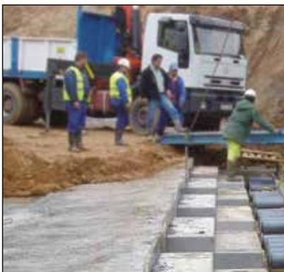
▼ Kontrollierter Betrieb von 32 Enerpac-Schwerlastzylindern zur Unterstützung des Baus eines neuen Brückenfundaments.
