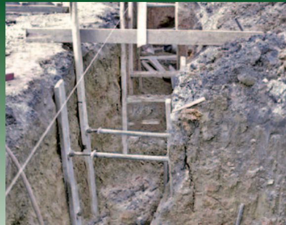
Les tirants pour tranchées Simplex série SE ont servi à étayer les parois de cette tranchée en vue de réparer des conduites d'eau souterraine.
