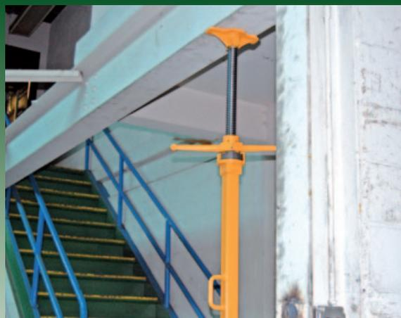
Diese Dachstütze der RS-Serie stützt einen horizontalen Doppel-T-Träger im Verlauf von Schweißarbeiten am vertikalen Doppel-T-Träger.
