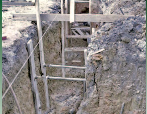
Die Graben-Abstandshalter der Simplex SE Serie stützen die Wände dieses Grabens während der Reparatur von im Boden verlegten Wasserrohren.
